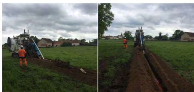
Figure 119 Exemple de chantier d'enfouissement d'un réseau électrique en terres agricoles
